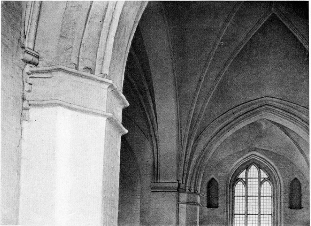
Fig. 9. Maribo. Indre visende skibets vestligste fag set mod nord. Helt til venstre ses fortandingen fra kormuren (s. 38).
