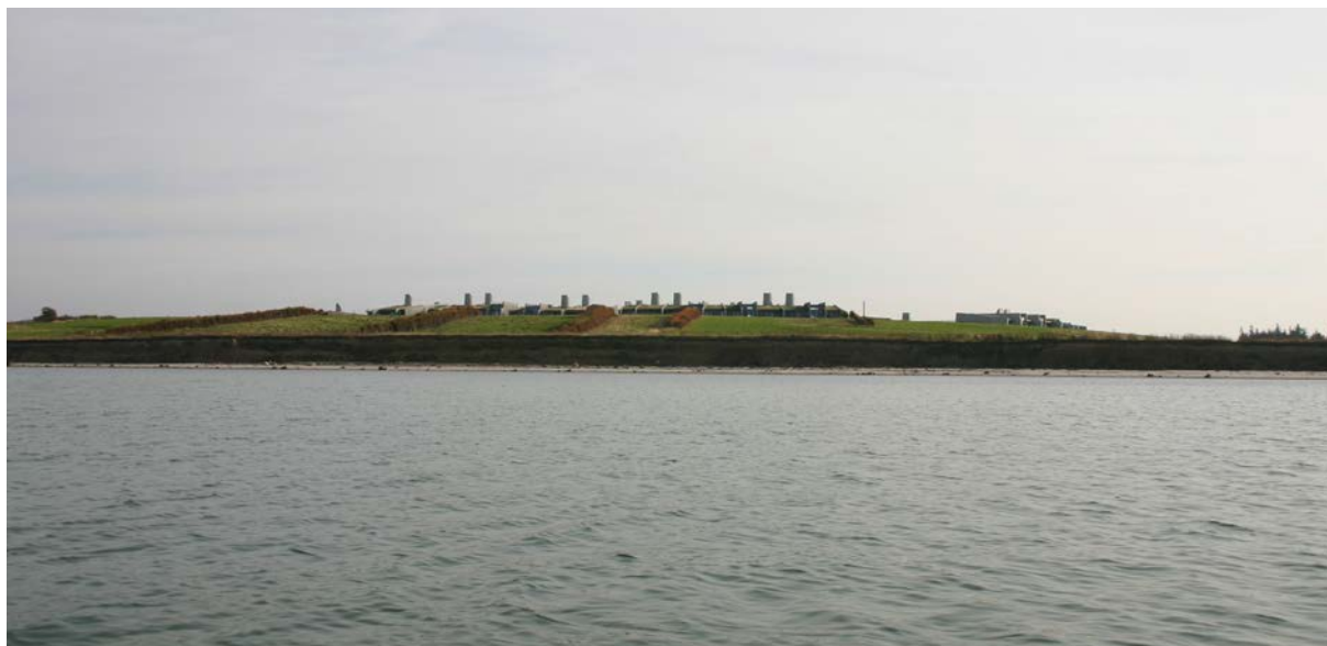
Fig. 3 - Billede af det eksisterende Musholm Bugt Feriecenter, set fra vandsiden mod syd.
